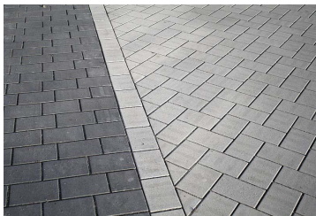
... sichere Entsiegelung durch Drainfugen.
